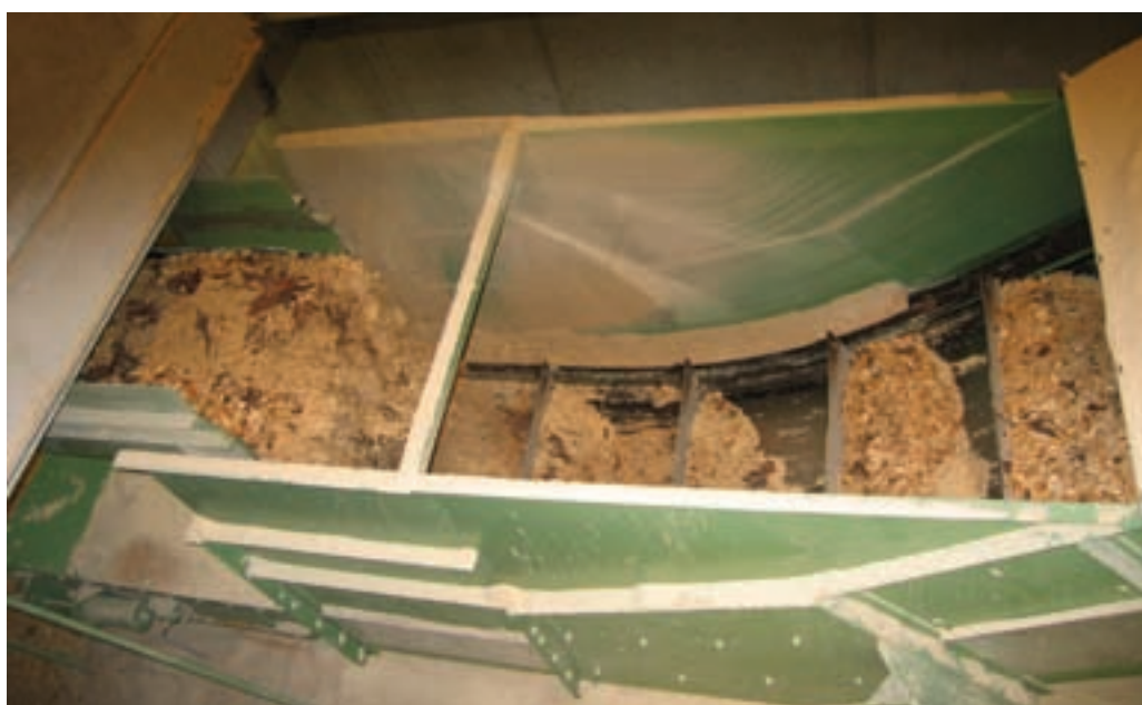
Innmatning av flis fra flislageret til forbrenningsanlegget (Arnold Kyrre Martinsen)
